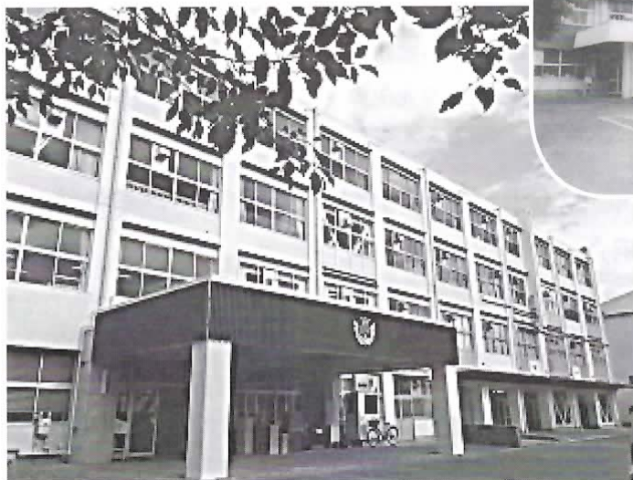
耐震工事完了後の正面玄関
