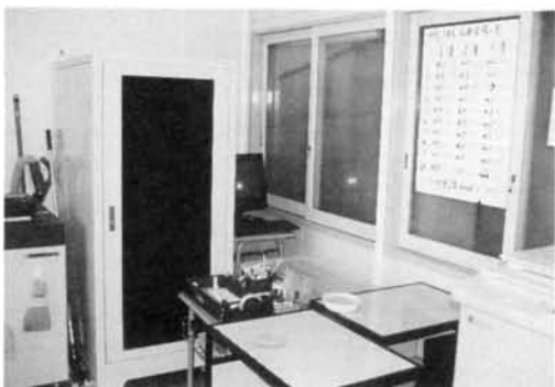
校内LAN設置（印刷室のサーバー）
