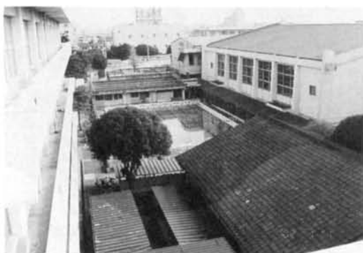
第三棟から見たプール
