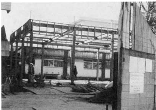
◀ トレーニング場新設工事 (平成十四年三月完成予定)
