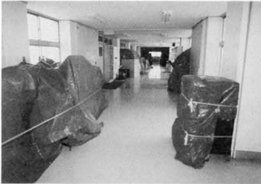
◀ 耐震大規模改造 (夏休み中物品は廊下に その一)
